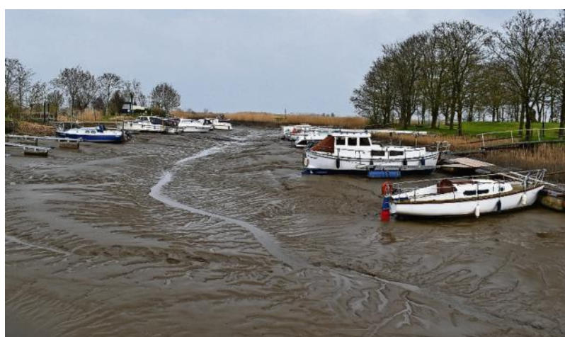
Dieses Bild zeigt das Ausmaß der Verschlickung im Frühjahr dieses Jahres im Hafen Absersiel vor dem Einsatz des Räumbootes. Stark betroffen sind auch die Hafentränder mit den Anlegestellen. Foto: Schnieder
